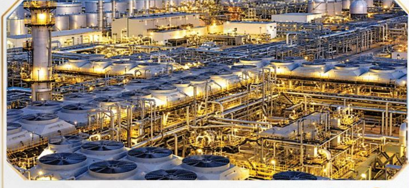
مشروع مصفاة بترو رابغ - رابغ
